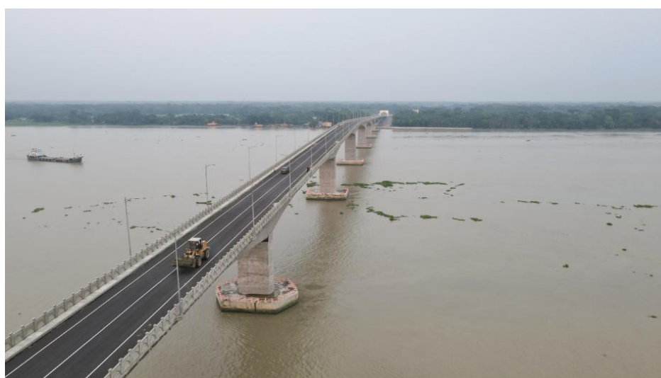
已经建成的友谊八桥项目
