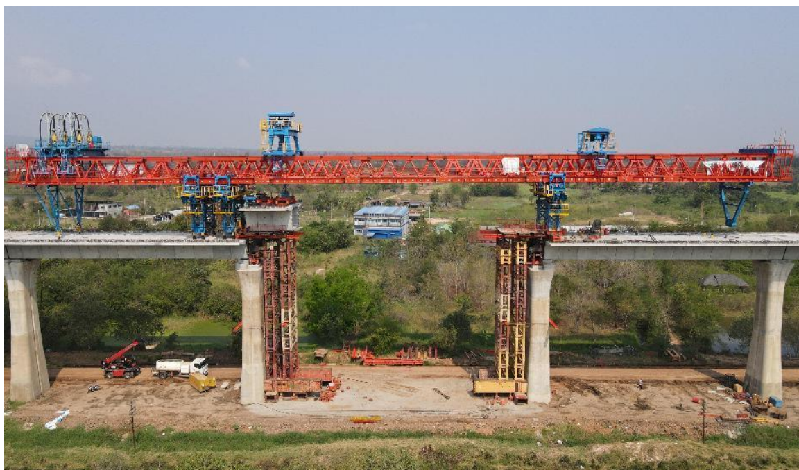
建设中的中泰铁路
