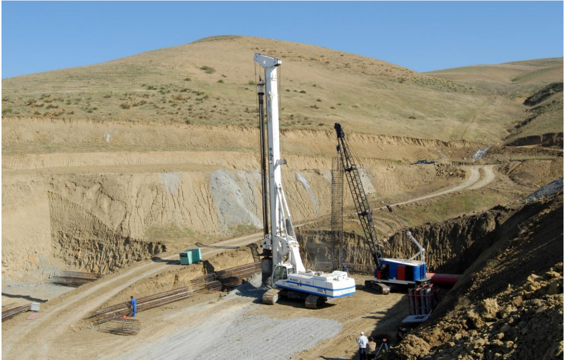
中信—中铁建联合体承建的东西高速公路
