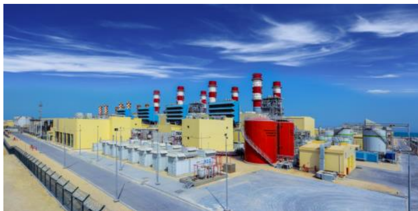
东电建三公司承建的巴林阿杜电站二期1540兆瓦燃机电站项目
