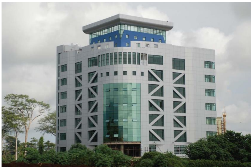
赤道几内亚总理府办公楼
