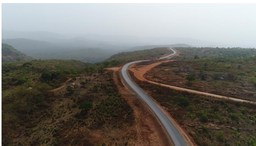
中国路桥承建的几内亚一号国道修复工程项目
