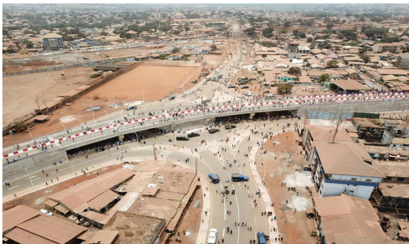
蚌埠国际承建的KAGBELEN立交桥
