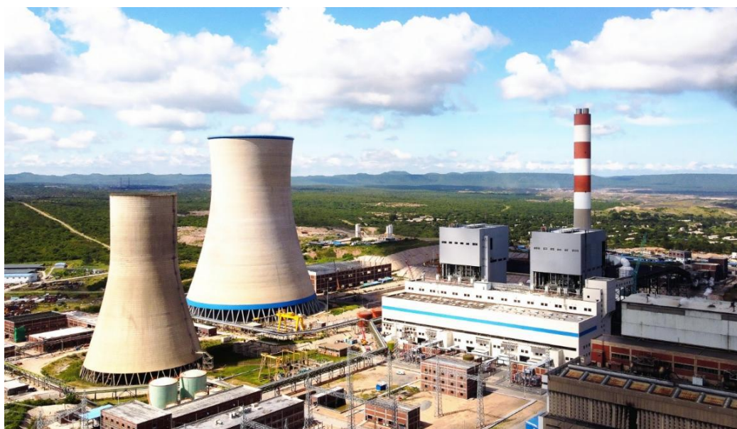
旺吉燃煤电站扩容项目
