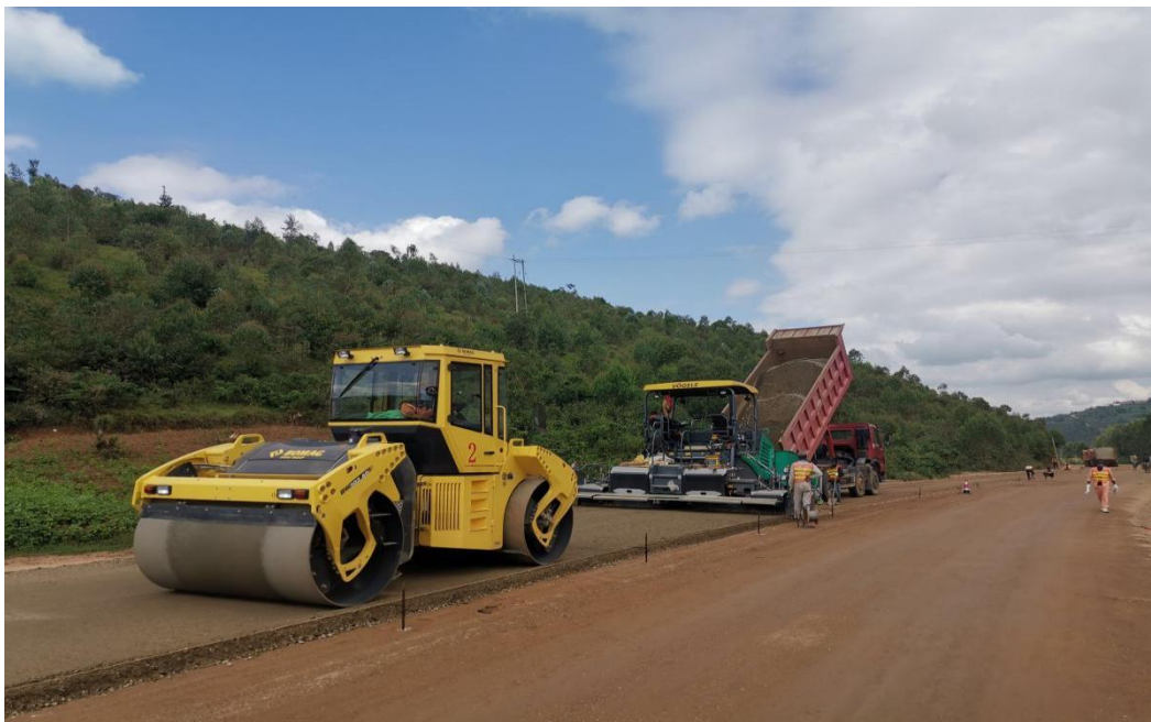
中国电建胡耶66公里路路面施工
