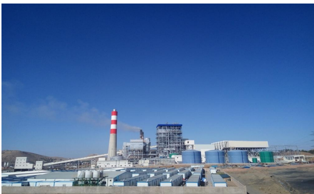
山东三建承建的杰拉达火电站项目
