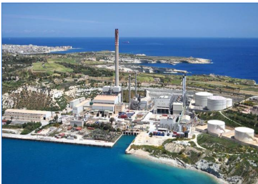
上海电力马耳他D3电厂
