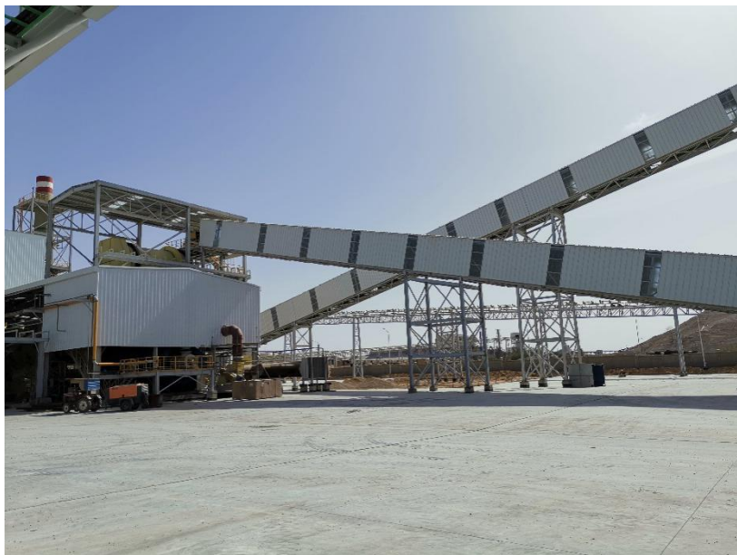
东华科技承建突尼斯化工集团项目
