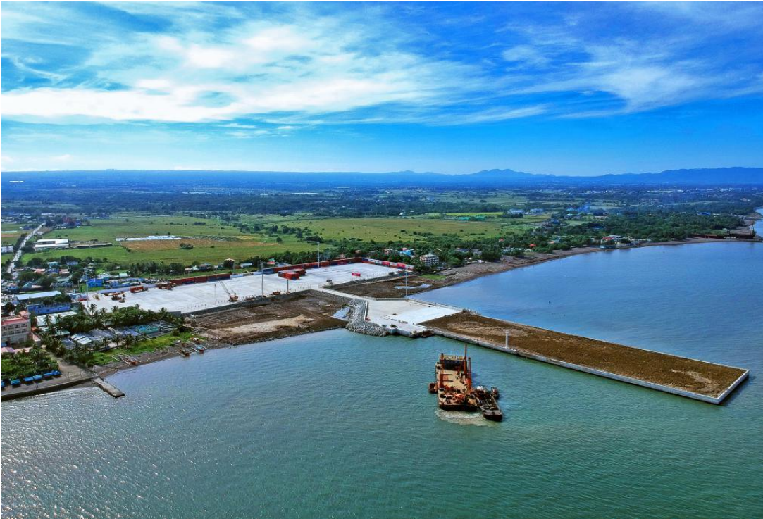
菲律宾甲米地集装箱转运码头升级改造项目（中国港湾承建）
