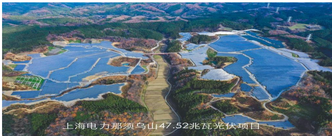
上海电力那须乌山光伏项目
